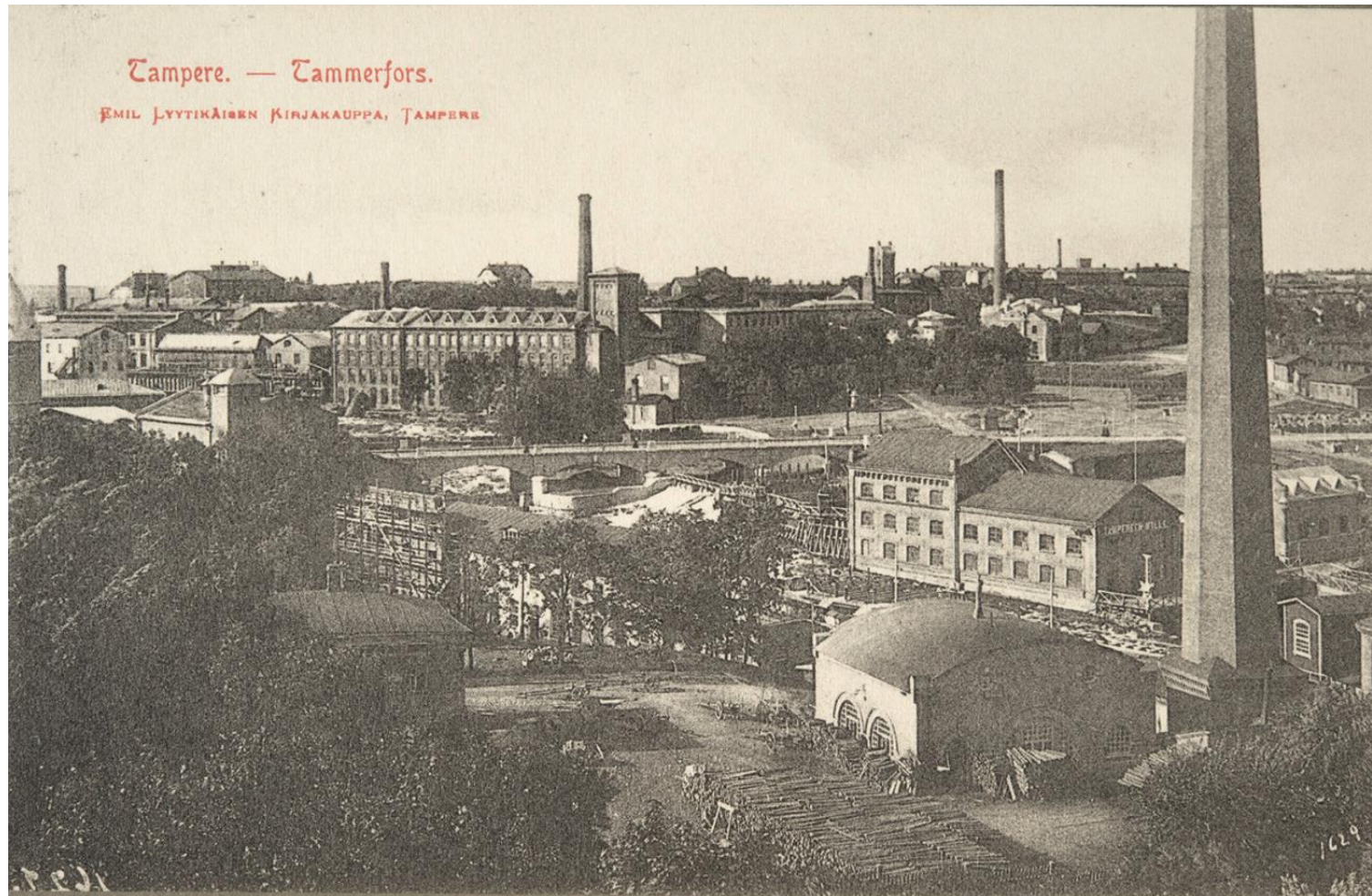
Kuva 12. Vanhan kirkon tornista otettu valokuva pohjoiseen 1900-luvun alusta. Kuvan oikeassa reunassa näkyy Frencellin savupiippu ja sen vieressä vuonna 1905 valmistunut pannuhuone. Pannuhuoneen takana näkyy Tammerkosken vastarannalla ollut Tampereen mylly, jonka paikalla on nykyisin Keskiputouksen voimalaitos. Pannuhuoneen edustalla on puupino. Kuvan vasemmassa reunassa näkyy Frencellin konttorin pihan kookasta puustoa sekä konttorin eteläpuolella olleen asuinkorttelin pihan puustoa ja rakennus. Kasvillisuuden takaa näkyy Frencellin lumppusiipi, jonka edessä on rakennustelineitä sekä koskisii-ven torni. (Kuvaaja Bardach. Historian kuvakokoelma, Museovirasto.)
