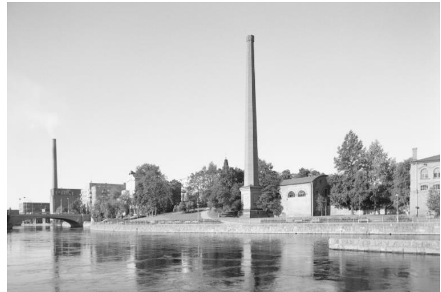
Kuva 26. Näkymä Tammerkoskelle ja Kirjastonpuistoon vuonna 1975. Kuvan vasemmassa reunassa näkyy Hämeensilta, oikeassa reunassa Frenckellin tehdasrakennuksia. Frenckellin piippu näkyy kuvan keskellä. Sen takana kasvaa kookkaita lehtipuita. Pannuhuoneen ja Frenckellin lumppusiiven välissä kasvaa kookkaita poppeleita, jotka todennäköisesti yhä ovat paikalla. Ilmakuviin perusteella ne on istutettu 1940-1950-luvulla paikalle. (Kuvaaja Teuvo Kanerva. Historian kuvakokoelma, Museovirasto.)
