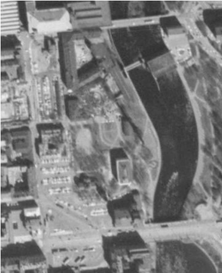
Kuva 21. Ote vuoden 1966 ilmakuvasista. Kirjaston pohjoispuolella olleet rakennukset Frenckellin entistä pannuhuonetta ja piippua lukuun ottamatta on purettu ja niiden tilalle on perustettu nurmikenttä kaartuvine polkuineen. Frenckellin edustan aukio on myös muutettu pysäköintialueeksi. Vuonna 1967 valmistunut Tampereen keskusvirastotalo ei vielä näy ilmakuvasissa. ( https://kartat.tampere.fi/oskari/ )
