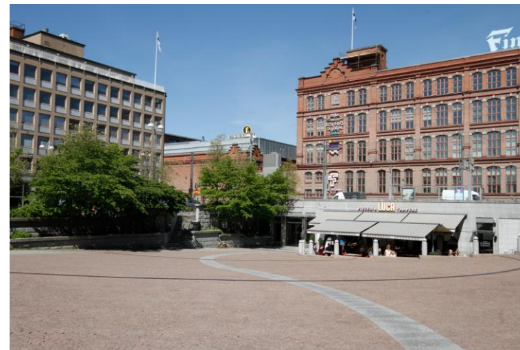
Kuva 36. Näkymä Frenckellin edustalta Frenckellin aukion yli kohti Satakunnan katua ja kadun alle rakennettuja liiketiloja.
