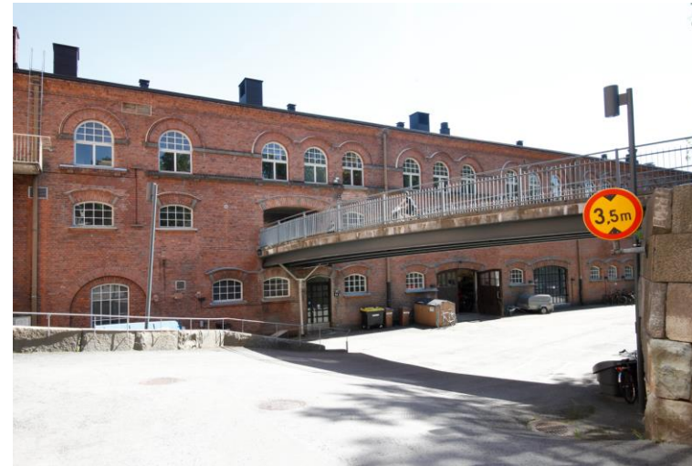
Kuva 35. Patosillan rakentamisen myötä Frenckellin lumppusiiven läpi avattiin jalankulun ja pyöräilyn väylä. Se kulkee sillalla lumppusiiven länsipuolelle.
