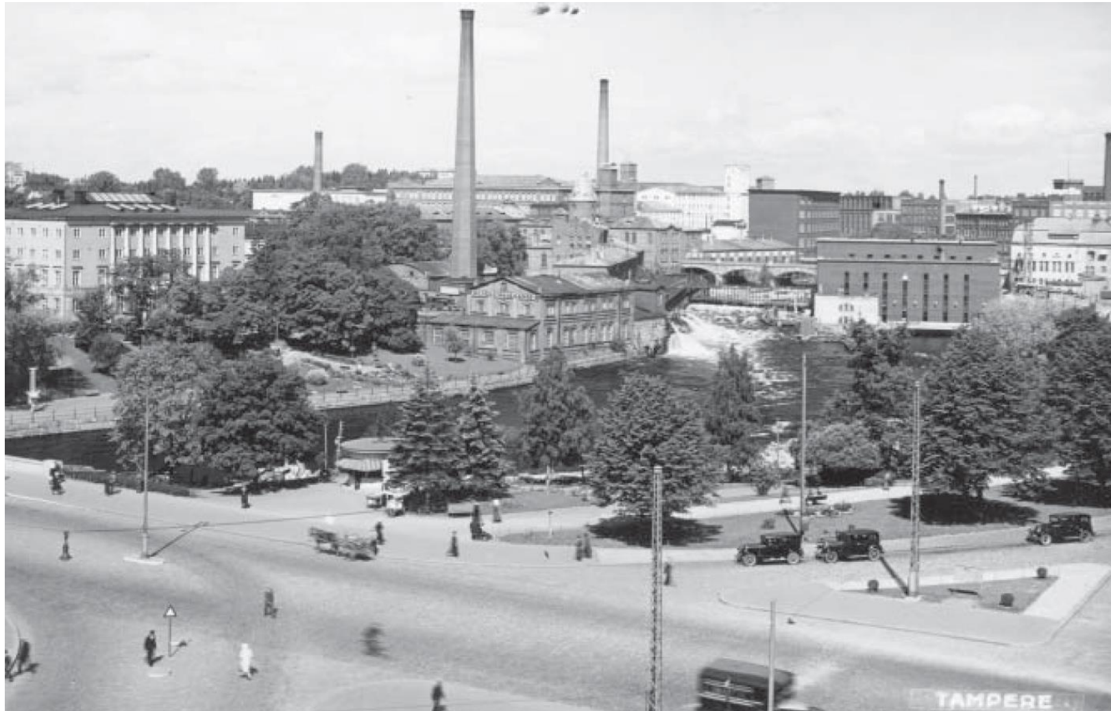
Kuva 16. Tarkemmin ajoittamaton näkymä luultavasti 1930-luvulta Hämeenkadulta Tammerkosken yli Kirjastonpuistoon ja Frenckellin tehdasalueelle. Kuvan vasemmassa reunassa näkyy kirjasto ja sen edustan puistoa, hahmotettavissa myös rantaan johtava puistoakseli ja pyöreä levähdyspaikka istutuksineen. Kirjaston oikealla puolella kosken rannalla on Frenckellin tehdasrakennuksia ja piippu. Piipun takana näkyy Frenckellin entinen pannuhuone. Sen takana näkyy Frenckellin konttorin ja tehdasrakennusten välissä ollutta lehtipuustoa. (Koskimaiseman puistot, 2005 [Tampereen museot, kuva-arkisto, Rasmussen].)
